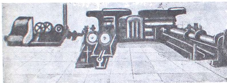
Фиг. 239. Стан Бриде для прокатки бесшовных труб.
